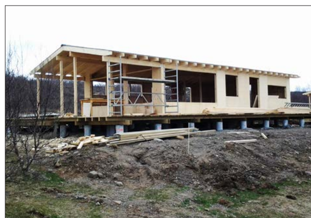
Myndin er frá uppbyggingu húsa nr. 72, 73, 76 og 77 við Stekkjarhól sem þegar hafa verið endurbyggð.
