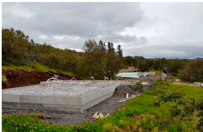
Grunnur að húsi við Eyrarhlíð.
