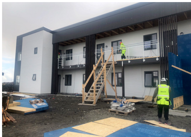
Heiðarstekkur 1 á Selfossi er timburhús sem byggt er úr kubbaeiningum sem SG hús framleiðir.
