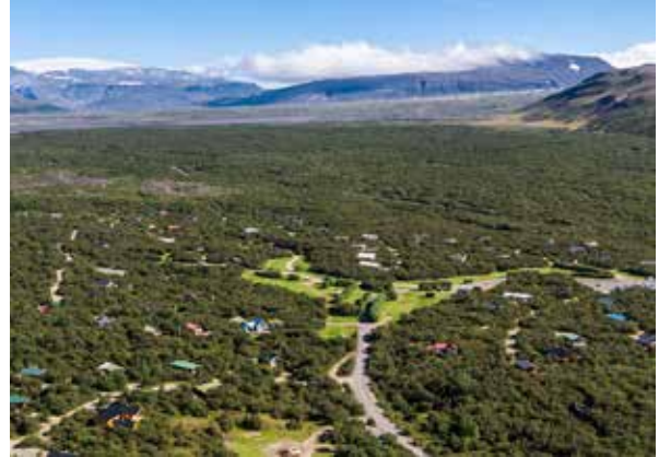
Endurbygging tveggja orlofshúsa í Húsafelli er vel á veg komin.
